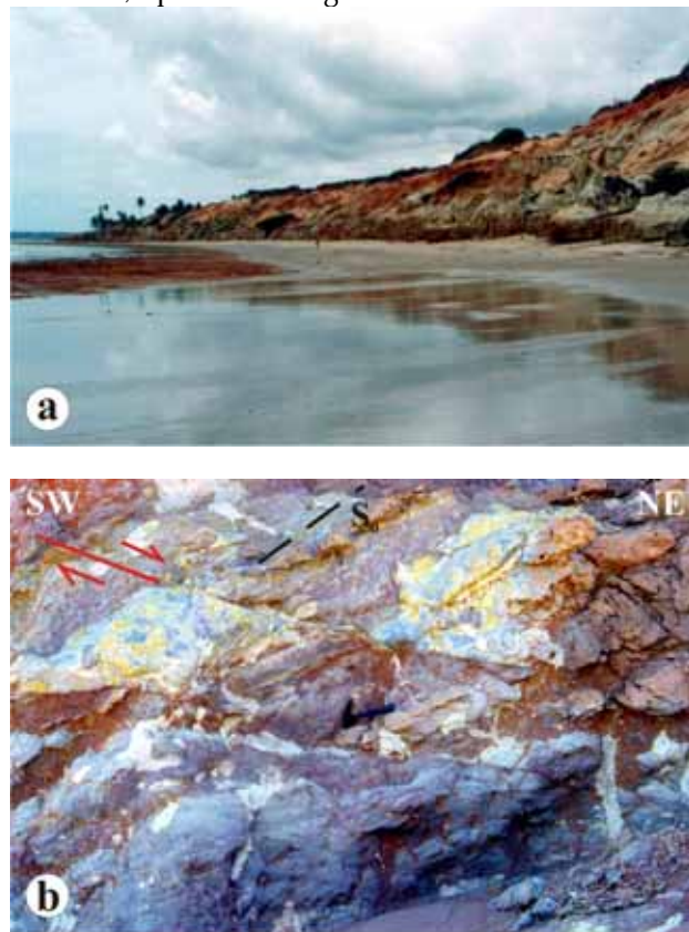
Figura 6 – (a) Camadas subhorizontais da Formação Barreiras e (b) falhas normais de baixo ângulo afetando as rochas da Formação Barreiras, com acamamento ( S_0 ) fortemente basculado, na localidade de Ponta Grossa.
