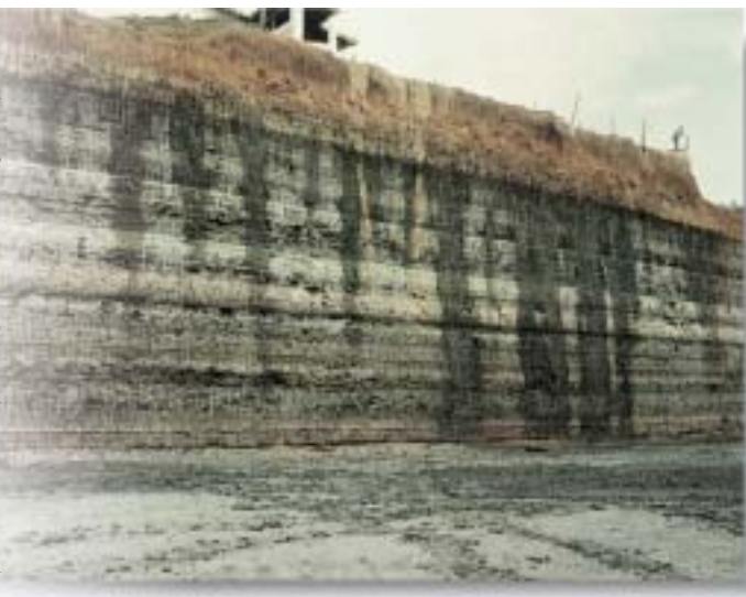
Figura 7 - Frente de exploração na Extrativa Santa Fé, em 1993, São observados os diferentes níveis de folheto pirobetuminoso e argilitos-siltosos, tendo na base a argila esmectícia.
