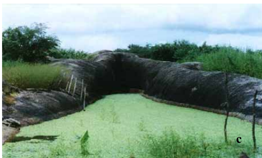
Fotos 33 – Situações de acumulação do Tanque Jirau/01, Área Piloto de Itapipoca, no período de 1 ano: (a) Seco (mês de janeiro); (b) Início da estação chuvosa (fevereiro) (c); Auge da estação chuvosa (abril).
