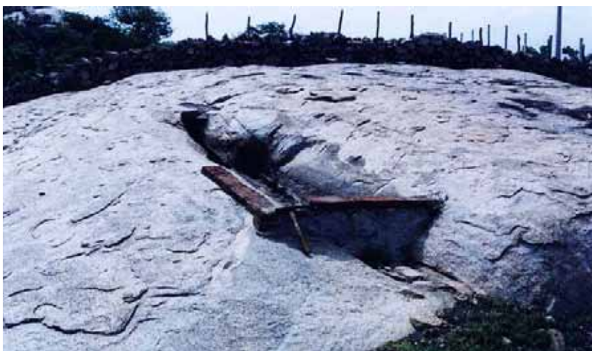
Foto 2 – Fenda na rocha, fechada com uma mureta, para acumular água. Loc. de Coité, Irauçuba, CE.
