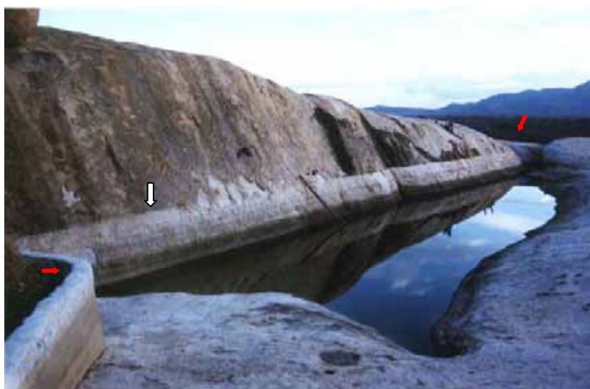
Foto 16 – Tanque do tipo aberto, já com mini-barragens instaladas (setas vermelhas). A seta branca mostra o nível d'água, quando o mesmo está na sua capacidade máxima, após a implantação das melhorias.
