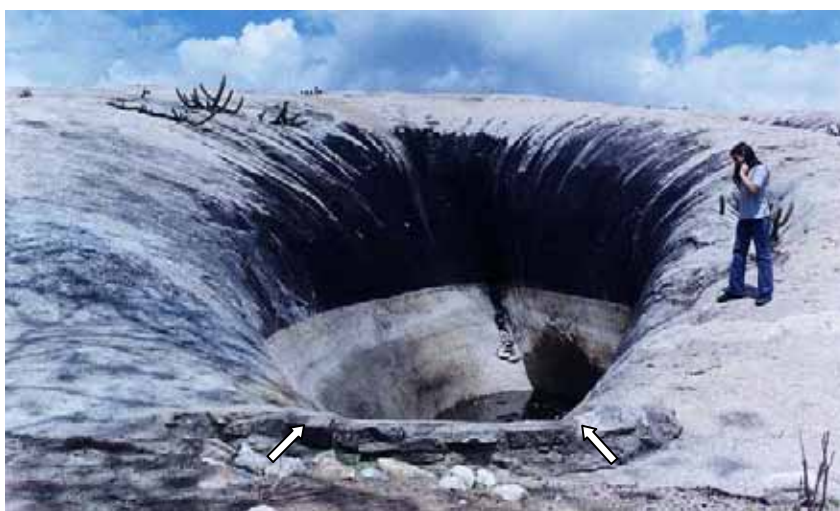
Foto 1 – Pequeno muro de alvenaria (setas) instalado em uma das extremidades de um tanque em Itapipoca, CE.
