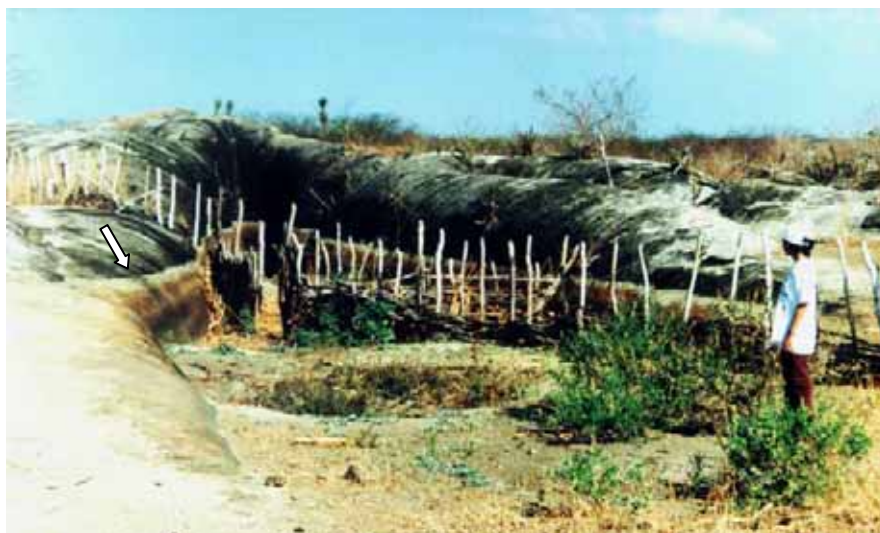
Foto 25 – Interior do tanque Jirau/01, do tipo semi-aberto, antes da escavação paleontológica. Observe pela marca d'água (seta) que a capacidade de acumulação fica bastante limitada tanto pelo pacote sedimentar como pela abertura na extremidade oposta.
