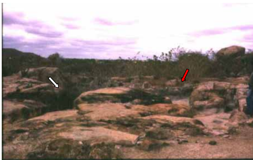
Foto 30 – Lajedo que forma o único micro-reservatório de Lagoa de Pedras, na Sub-área Irauçuba. A seta branca mostra o tanque propriamente dito. A seta vermelha mostra uma das seis muretas instaladas para aumentar a capacidade de acumulação.
