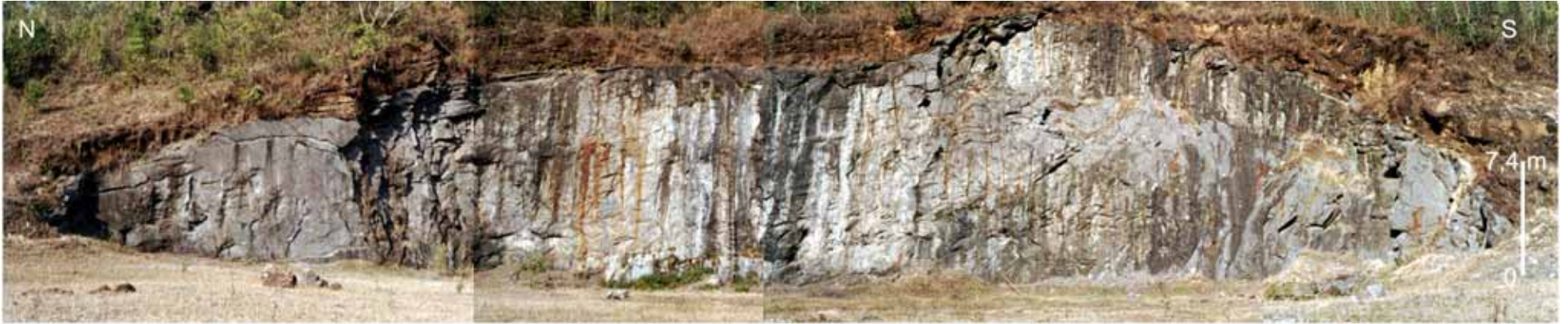
Figura 17 - Vista geral da pedreira em diamictitos de Couto de Magalhães de Minas (Queiróz 2002)
