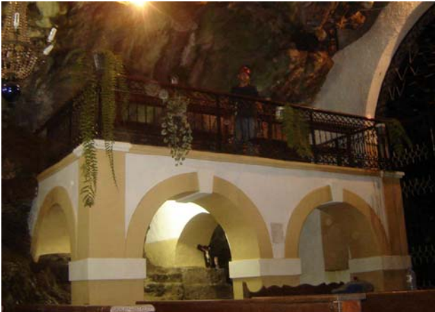
Figura 06 - Estrutura para sustentar o coreto.
